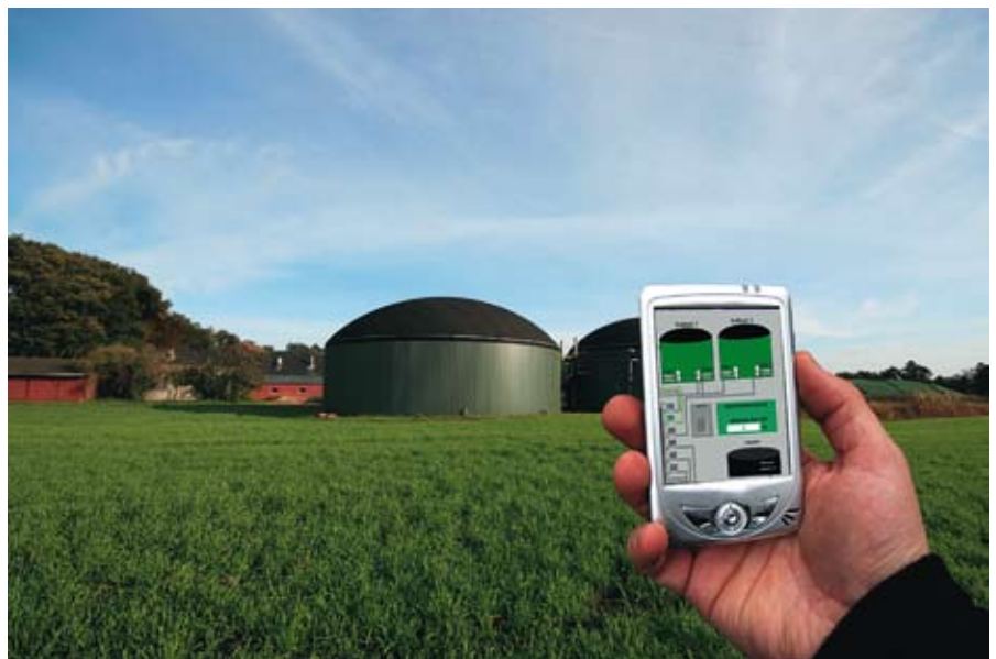
▲ Mobile Lösungen bei der PlanET Anlagensteuerung sorgen dafür, dass alle Komponenten der Biogasanlage zu jeder Zeit unter Kontrolle sind.
